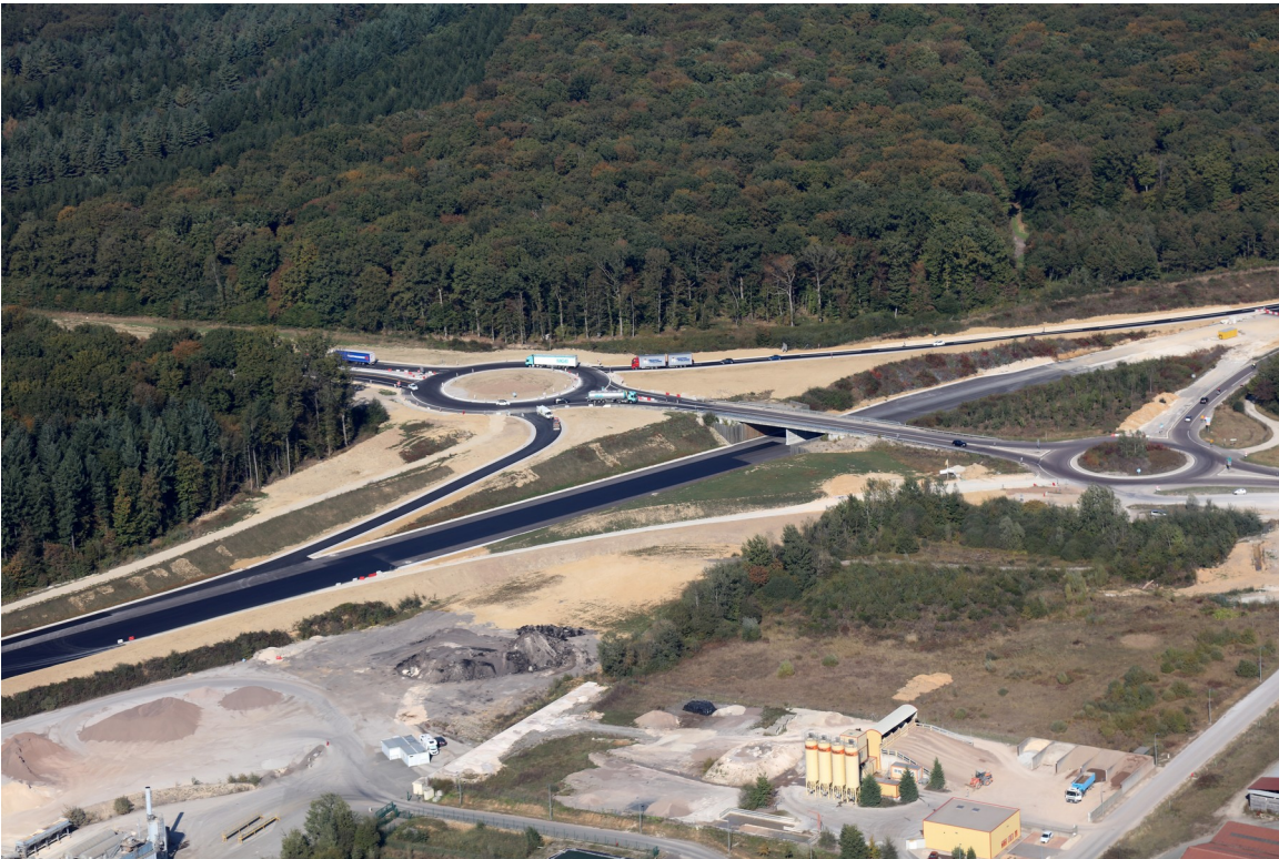
Raccordement à la RD 64
